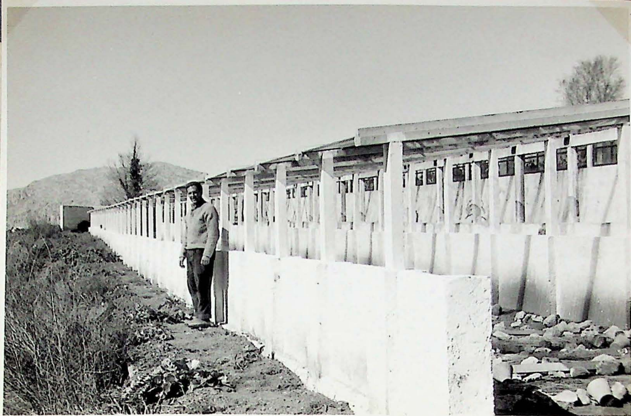
Vivero Central de "Manut" Primer plano del invernadero construido en el año 1963.
