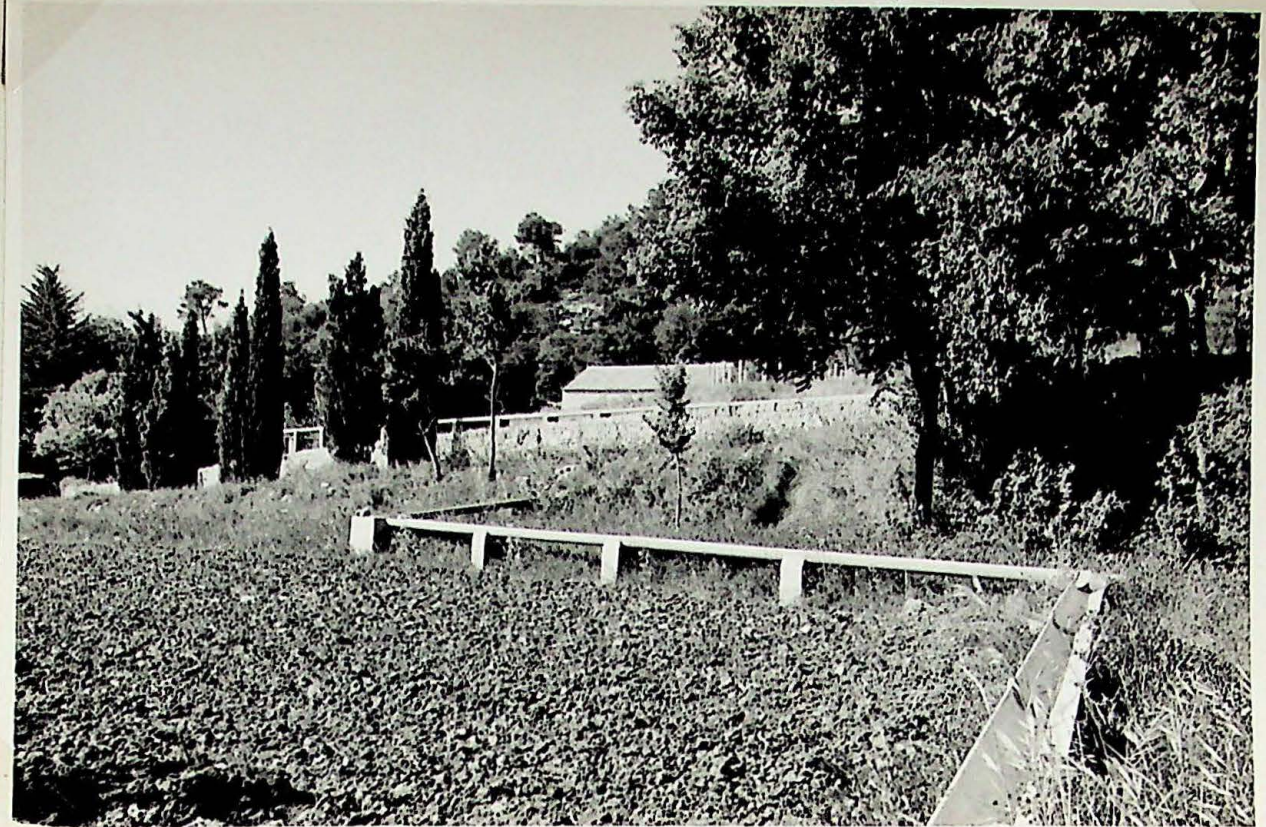
Vivero Central de "Manut" Conducción de agua, procedente de aljibes, por medio de canales de uralita con sus arquetas.
