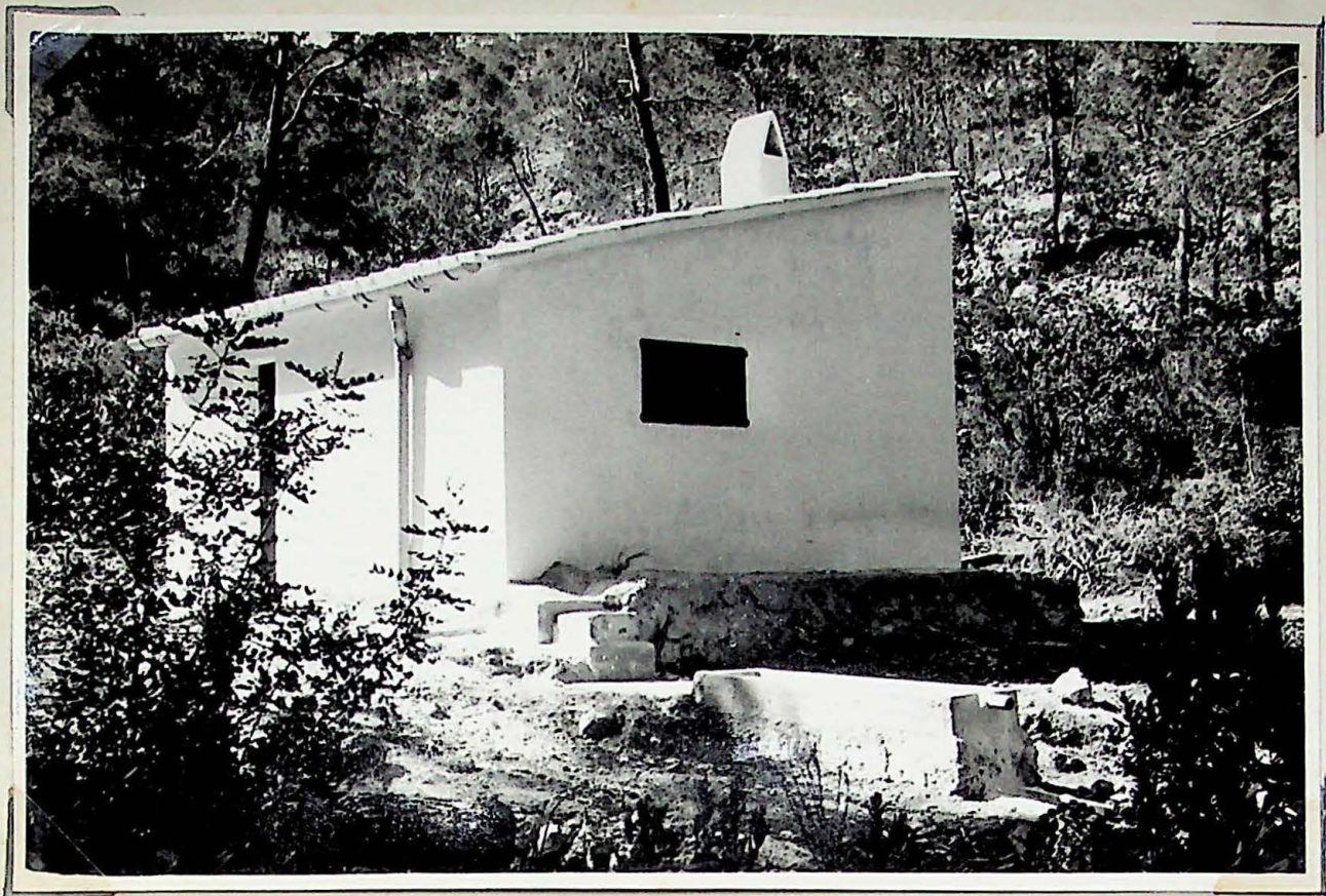
Idem. idem. Fachada este, con el abrevadero.
